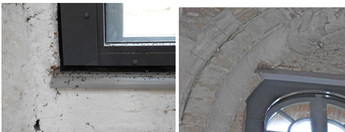
Figuur 12: Gebruik van de raamkozijnen als wegkruipplek. Rechts nog een van de weinige nog duidelijk aanwezige invlieg/ doorkruipplekken.
