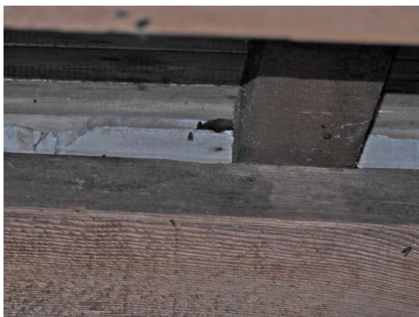
Figuur 3: Een van de wegkruiplekken van gewone dwergvleermuizen in de nok van de warmere dwarszolder.
