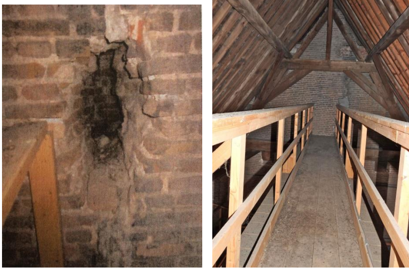
Figuur 8: De doorgang van de zolder naar de toren. Situatie begin 2012 en de huidige geblokkeerde situatie in 2016.
