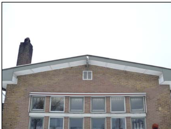
Figuur 4.5 Daklijsten realiseren in de nieuwbouw
