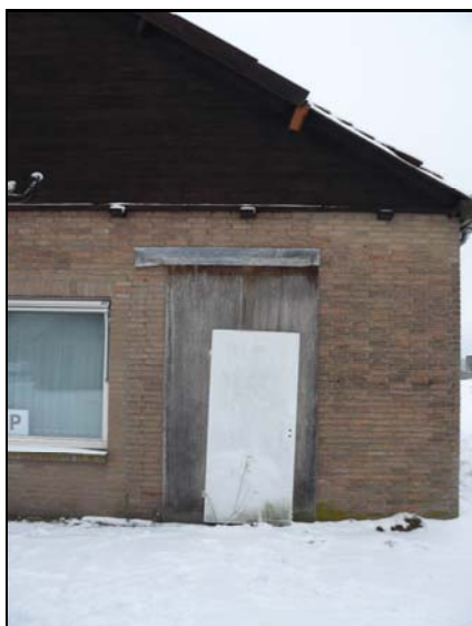
Figuur 1 Gebouw B
