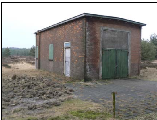
Figuur 8 Dieselloods naast het zendstation
