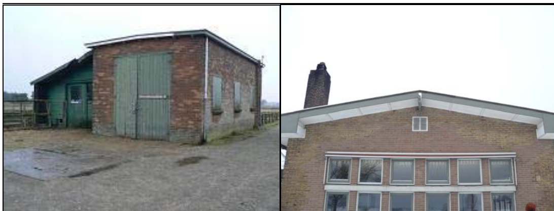
Figuur 7 Links dieselloods bij E en daklijst van de gebouw C
