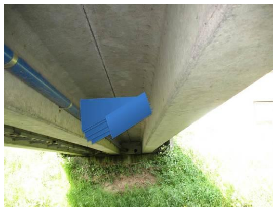
Figuur 9: beeld van lamellen onder de brug naar de Lindehof
