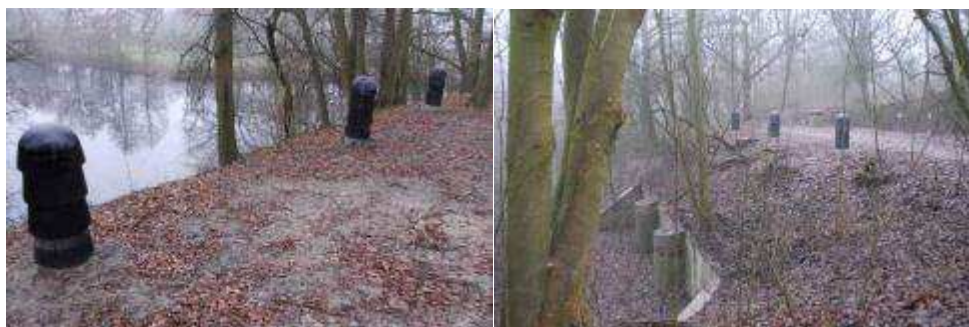
Figuur 15: Open kruitdampkanalen zijn hier door het dichtten van de bovenkant en zelfs door er speciale keramische potten voor vleermuizen op te plaatsen, veranderd in dichte warme tochtvrije schoorsteenkanalen die van onderaf toegankelijk zijn (situatie Vechten).
