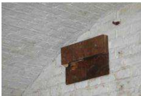
Figuur 23: Verwijder de schimmelden kastjes, en hang op locatie nieuwe wegkruipstenen op
