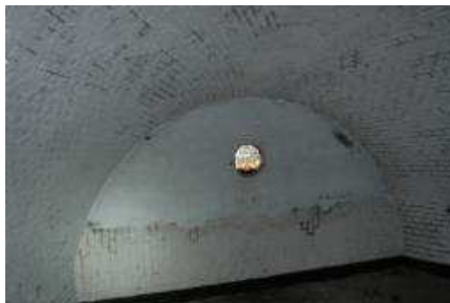
Figuur 81: Niet te passeren door vleermuizen. Horizontale spijlen gebruiken of spleet maken van 20 x 4 cm.
