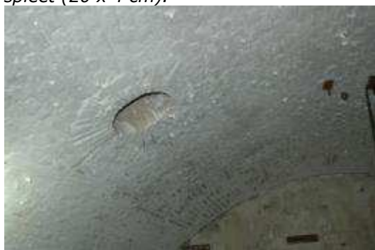
Figuur 82: Een van de af te dekken kruitdampkanalen
