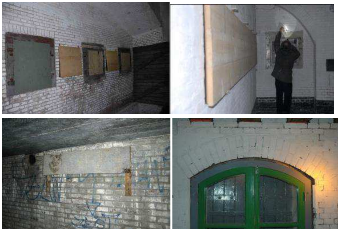
Figuur 10: Het aanbrengen van extra wegkruiplekken kan door het aanbieden van wegkruipplaten van ruw houten planken (vuren) of houtwol cement platen. Deze voorzieningen gaan ca. 8-16 jaar mee. Ook het op afstand plaatsen van houten raam- en deurkozijnen biedt vleermuizen wegkruipmogelijkheden die snel gebruikt worden.
