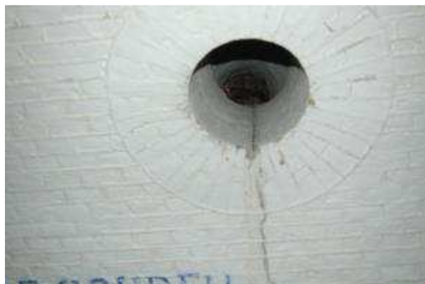
Figuur 73: Een van de af te dekken kruitdampkanalen
