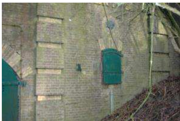
Figuur 53: Het luikje aan de keelzijde
