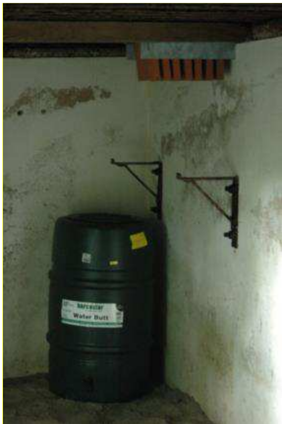
Figuur 6: de luchtvochtigheid kan worden verbeterd en beheerst door middel van een laag schoon grof zand (ca. 25 cm) op de vloer en/of met een waterton met een druppeluitgang.
