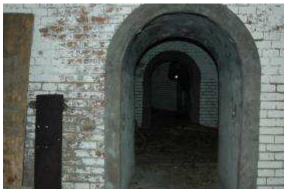
Figuur 106: Het interieur van de kelderruimte van Open remise 1. Er zijn geen wegcruiplekken.
