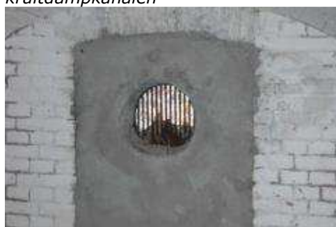
Figuur 75: Niet te passeren voor vleermuizen
