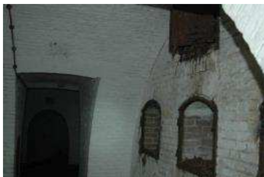
Figuur 30: De ventilatieluiken van de geweergang
