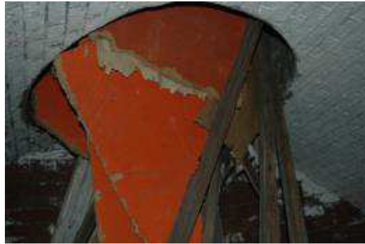
Figuur 102: Gebruikt als afvalstortplek.
