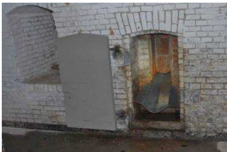
Figuur 7: Waar druipkokers aanwezig zijn kunnen deze voor het verbeteren van de (lucht)vochtigheid worden gebruikt. Een zinken plaat zorgt voor uitvloeien van het water uit de druipkokers over de vloer, en voorkomt tegelijkertijd het verdrinken van vleermuizen in de waterkelders.
