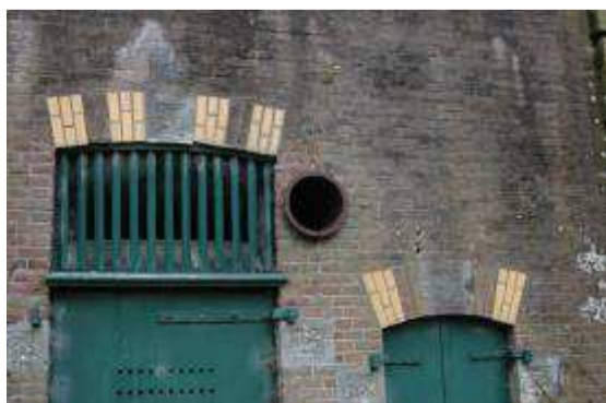
Figuur 64: De door uilen gebruikte toegang (ronde buis) en de niet door vleermuizen gebruikte ingang met verticale spijlen (buiten aanzicht)
