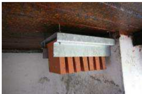
figuur 13. Wegkruipmogelijkheden kunnen worden gecreëerd door keramische platen op verschillende afstanden van elkaar te hangen. Beter was het als ook de zijkanten over de gehele breedte dichtzaten. Dit is ook mogelijk met keramische dakpannen.
