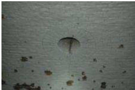
Figuur 25: Het af te sluiten kruitdampkanaal
