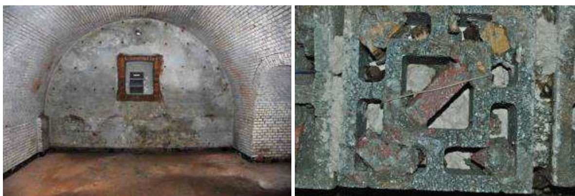
Figuur 11: Het maken van extra wegkruiplekkendoor het aanbrengen van boorgaten (hier fort Vechten) of wegkruipstenen (Groentekelder Molenbos) is een meer duurzame oplossing en hebben geen vervanging nodig.
