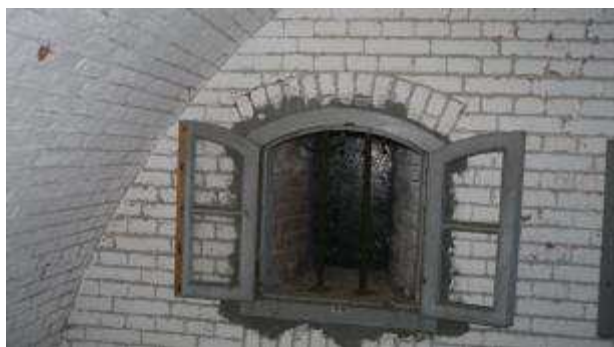
Figuur 18: Sluit de meeste kruitdampkanalen tochtdicht af. Figuur 19: Sluit de luiken permanent
