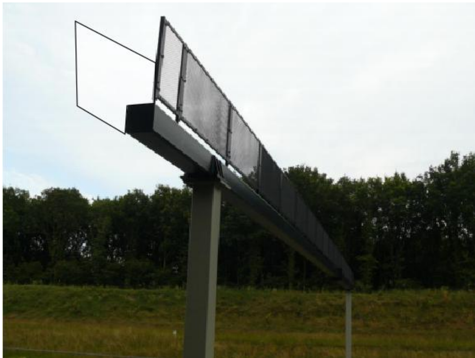
Figuur 16: Een van geperforeerde stalen platen gemaakte hop -over geplaatst op een standaard verkeersportaal. In Eindhoven is een dubbele scherm nodig. (Ook is een betere groene aanbinding nodig).
