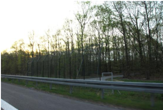
Figuur 18: Voorbeeld van een scherm om vleermuizen te dwingen bij de weg hoog te gaan vliegen.
