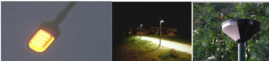
Figuur 19: Voorbeelden van fietspadverlichting met verbeterde lichtkleur (Amber), optiek en een met folie afgeschermd lichtpunt (bron RW & MJPO).
