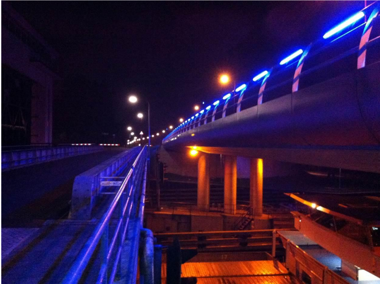
Figuur 10 Noordzijde van Beatrixsluis, verlichtte weg (Weg van de Binnenvaart/Waterliniedok). Links op de foto is nog net een heftoren zichtbaar.
