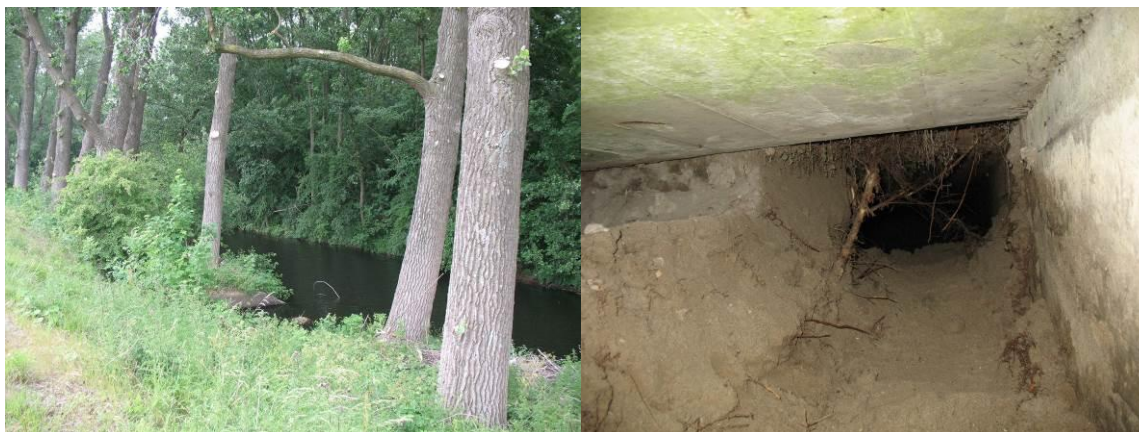
Figuur 5 Het oude afwateringswerk bij de Schalkwijkse wetering (huidige situatie)
