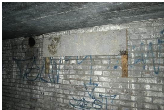
Figuur 4: Houtwolcementplaten als wegkruipmogelijkheden
