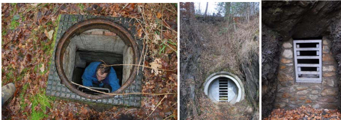
Figuur 3: Een inspectieput en een afgesloten rioolbuis als “menselijke” toegang tot een vleermuiswinterverblijf. Rechts een siermuurtje met beton, 4 houders en 4 slotkasten. Rechter twee ontwerpen door ® J. Koettnitz.
