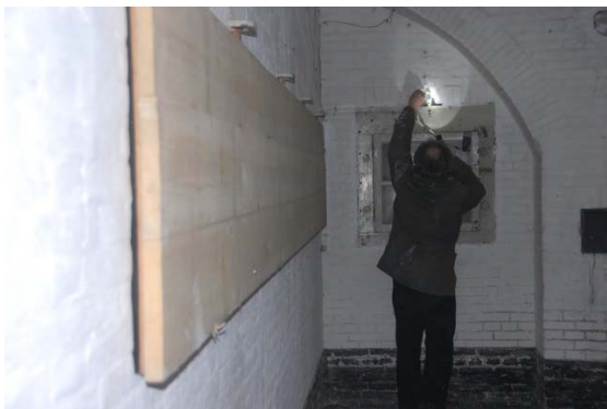
Figuur 9: Speciaal voor vleermuizen aangebrachte ruw vuren wegkruipplaten, (onderzijde open).
