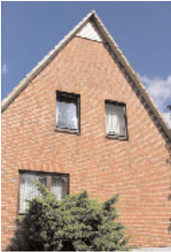
Figuur 5. Foto voorbeeld van eenvoudig topgevelbetimmering
