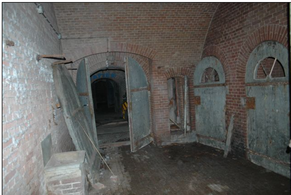
Het noordelijk deel van gebouw LL; de ruimte deuren van de privaatruimten en druipkoker van gebouw LL, de belangrijkste vleermuisplekken in de winter (situatie 2003/2004).
