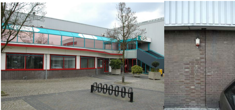
4. Kantoor+partycentrum, detail zijmuur Voordorphal
