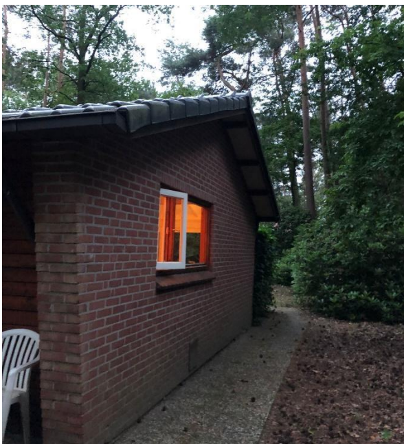
Afbeelding 4.3 | De kolonie Brandts vleermuizen verbleef onder de dakpannen van deze vakantiewoning (frequentie 151.4350). (Foto: Marco Snijder)
