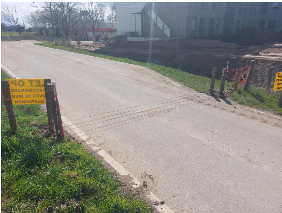
De stroomdraden bij de doorgang van de bouwweg door het raster zijn rerepareerd en beter afgespannen dmv extra paaltjes.
