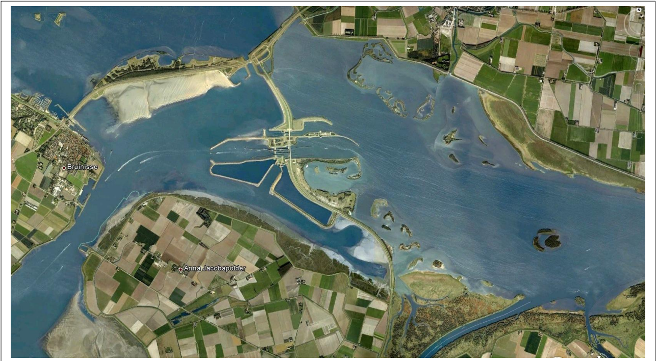
Figuur 2. De Philipsdam vormt de scheiding tussen de Oosterschelde en het Volkerak-Zoommeer, aan de noordzijde ligt de Grevelingendam en daarachter het Grevelingenmeer. De Kramer (het deel van het Volker-Zoommeer waar de Philipsdam aan grenst) is zoet - vast peil, Grevelingen: zout - minigetij en Oosterschelde zout – getij.
