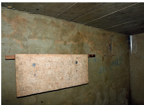
Figuur 2. Type vleermuiskast dat is geïnstalleerd in de bunkergangen-complexen. Foto: Christian Dietz.
