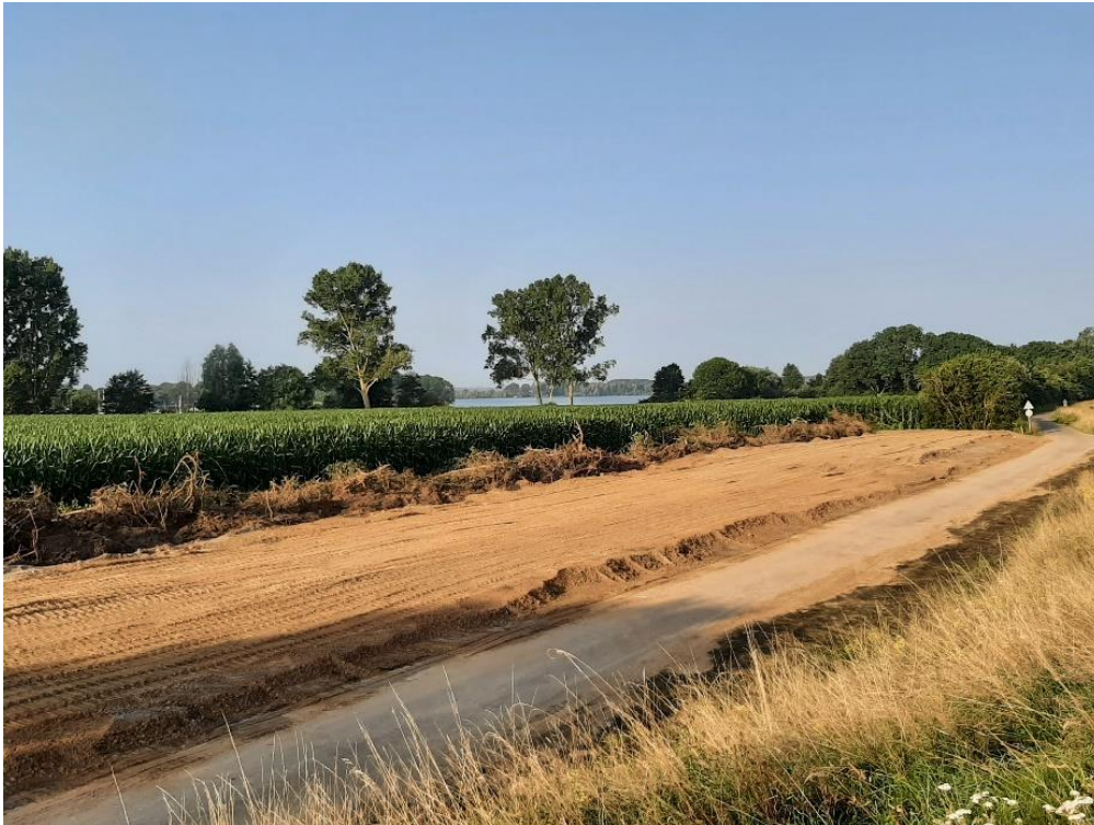
Figuur 6. Aangelegde steunberm aan de Lommerstraat.
