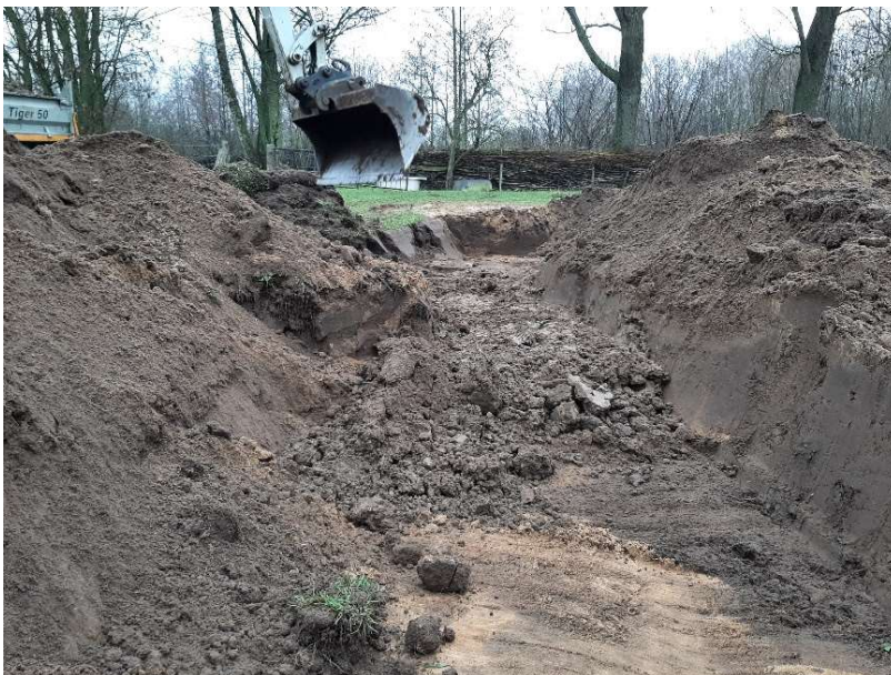
Foto 4. Locatie D met twee dassenpijpen.
