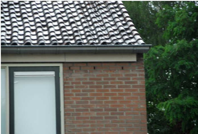
Figuur 4: Gevel met open stootvoegen, de middelste en linker invliegopening worden door de gewone dwergvleermuis gebruikt.
