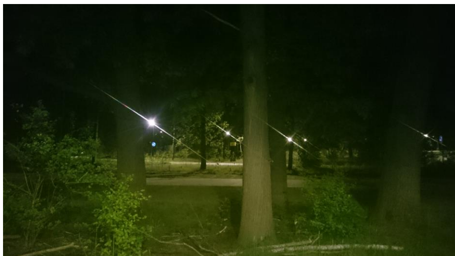
Figuur 3: Verlichting op de parkeerplaats in een situatie waarin er 's avonds nog activiteiten in het hoofdgebouw plaatsvinden.
