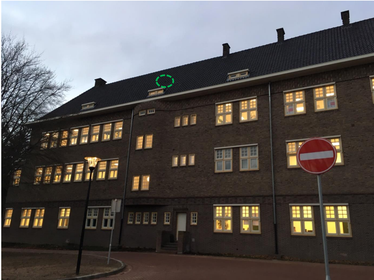
Figuur 21. Aan de zijde van de Houtlaan is een ventilatiepan aangebracht. Vleermuizen hebben hierdoor een toegang tot de zolder.
