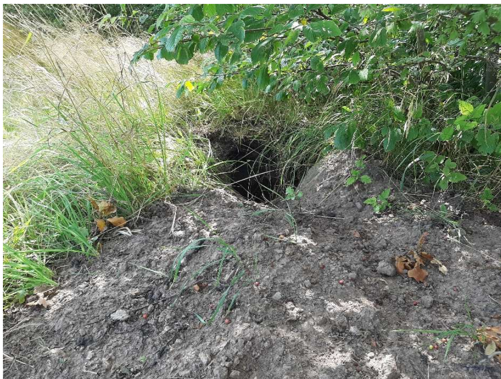
Figuur b6 Vluchtpijp aan Flinkebosje
