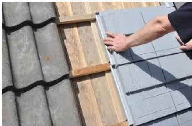
Figuur 2.8. Aanbrengen van RecaPan elementen
