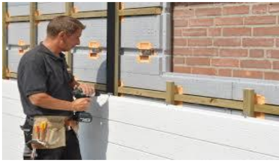
Figuur 2.17. Isolatie aan de buitenzijde.
