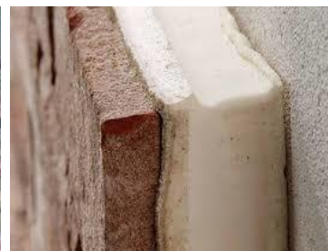
Figuur 2.15. Spouw met foam
