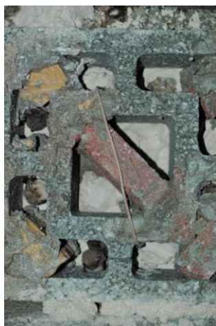
Figuur 7: Drie voorbeelden van wegkruipmogelijkheden voor vleermuizen; een aangepaste patiosteen, schuin opgehangen wegkruipplaten (hier van hout) en een afgedekte snelbouwsteen met grote gaten. Hier was de steen niet ruw gemaakt en de vleermuis kon er niet inkruipen, maar is erachter gaan zitten.
