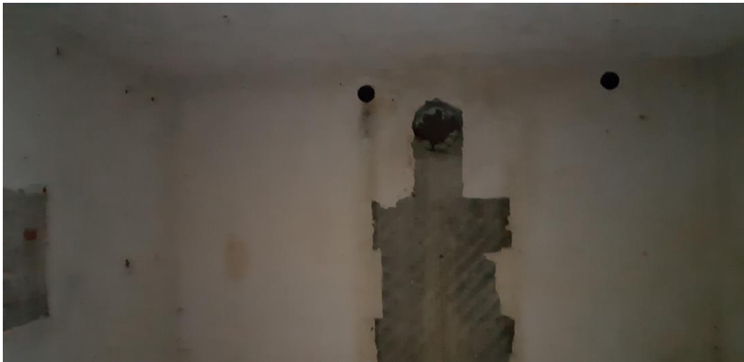
Figuur 12 : Oude ventilatie opening in westwand gebouw (foto van binnenuit).
