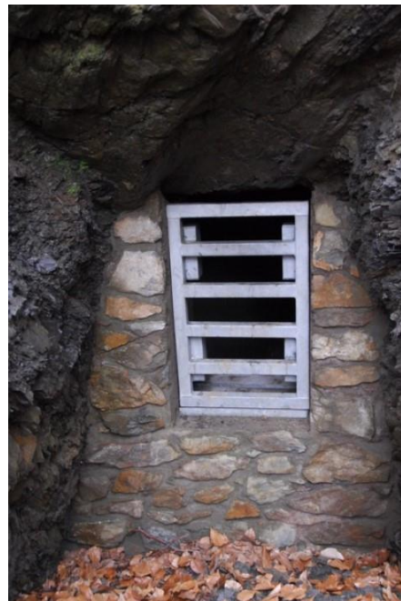
Figuur 12 : Twee typen verzinkte luiken met slot ogen en slotkasten. De vierkante dwarsstangen zijn aangestampt gevuld met beton en een hardstalen ronde kern tegen het doorslijpen. Rechts het luik in situ. De onderkant staat op een ingegoten rand. De houders zijn T-vormig en worden met lange chemische muurbouten verankerd.
