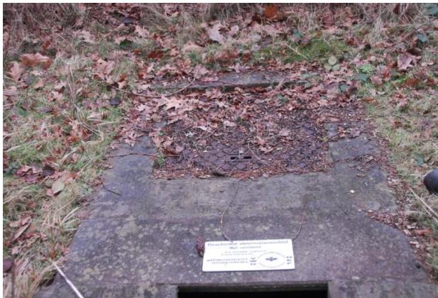
Figuur 10 : Een bunkerafsluiting met een putdeksel oude situatie. Nu wordt deze deksel met grond afgedekt.
