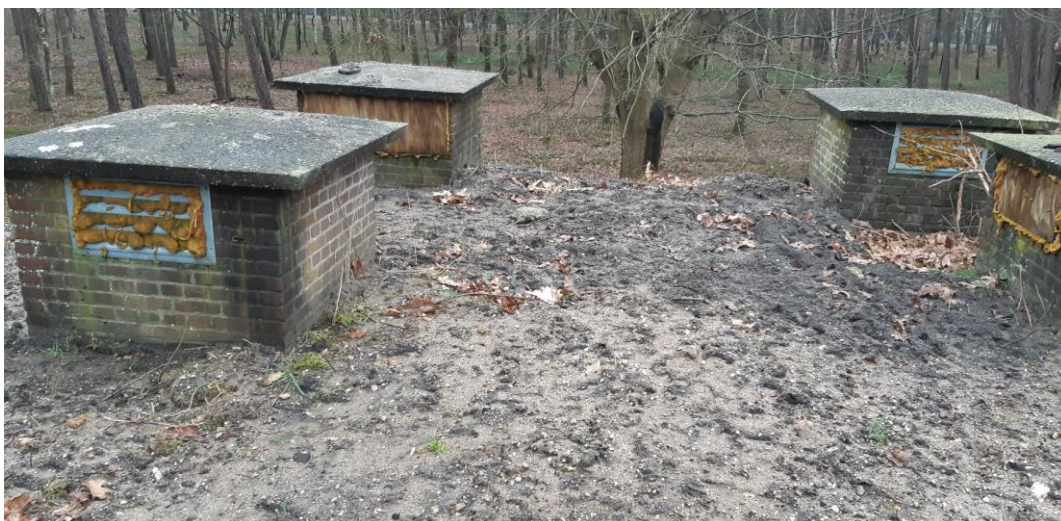
Figuur 13 : De vier schoorstenen (schacht ligt linksvoor net buiten de foto). De linker twee zijn te verhogen tot op 1,8m hoogte boven grondniveau, deze worden de toegangen voor vleermuizen. De rechter twee worden verlaagd tot grond niveau. De toegangsschacht wordt de verborgen inspectietoegang.
