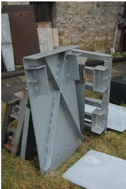
Figuur 12 : Twee typen verzinkte luiken met slot ogen en slotkasten. De vierkante dwarsstangen zijn aangestampt gevuld met beton en een hardstalen ronde kern tegen het doorslijpen. Rechts het luik in situ. De onderkant staat op een ingegoten rand. De houders zijn T-vormig en worden met lange chemische muurbouten verankerd.
