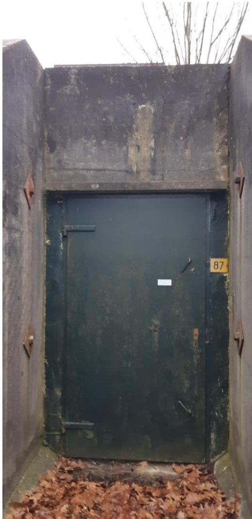
Figuur 14 : De ingang met toegangsdeur, situatie januari 2021.
