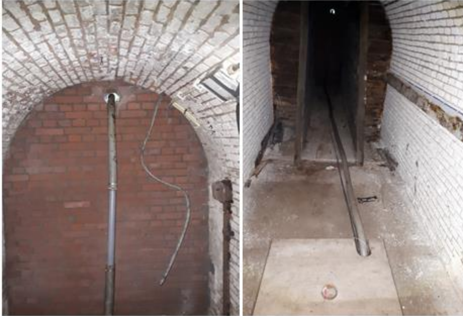
Figuur 8: Schematisch voorbeeld van hoe een buis kan worden gebruikt om de luchtstroom in de gang onder poterne te laten ontstaan. Rechtsonder is het houten luik te zien waarin de sleuf met kraag wordt gemaakt. © Herman Limpens
