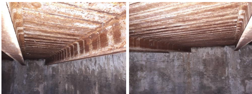
Figuur 10: metalen balklaag onder de 'deksel op de centrale koker'.
