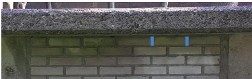
Figuur 4: Voorbeeld van locatie waar twee stootvoegen kunnen worden doorgeboord. © Herman Limpens
