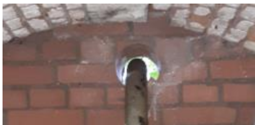
Figure 7: voorbeeld van gat in de eensteens muur waarmee de poterne is afgesloten. © Herman Limpens
