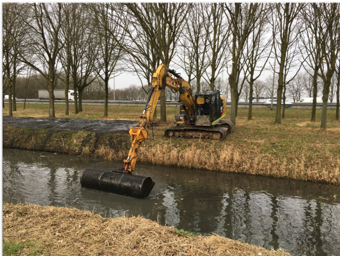
Figuur 4. Voorbeeld van een kraan waarmee wordt gebaggerd, waarbij het slib over de kant wordt uitgespreid (bron: Waterschap Rivierenland).
