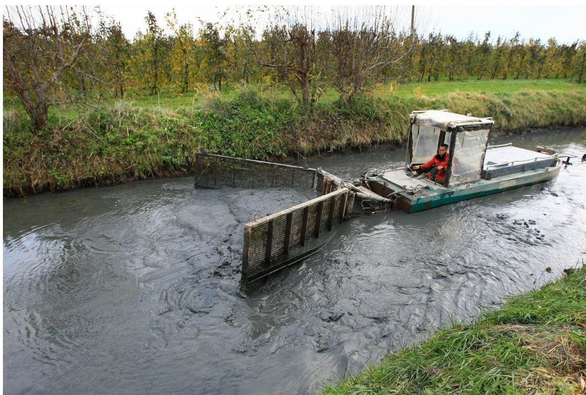
Figuur 5. Voorbeeld van een schuif die met behulp van een bootje wordt voortgeduwd (bron: Waterschap Rivierenland).
