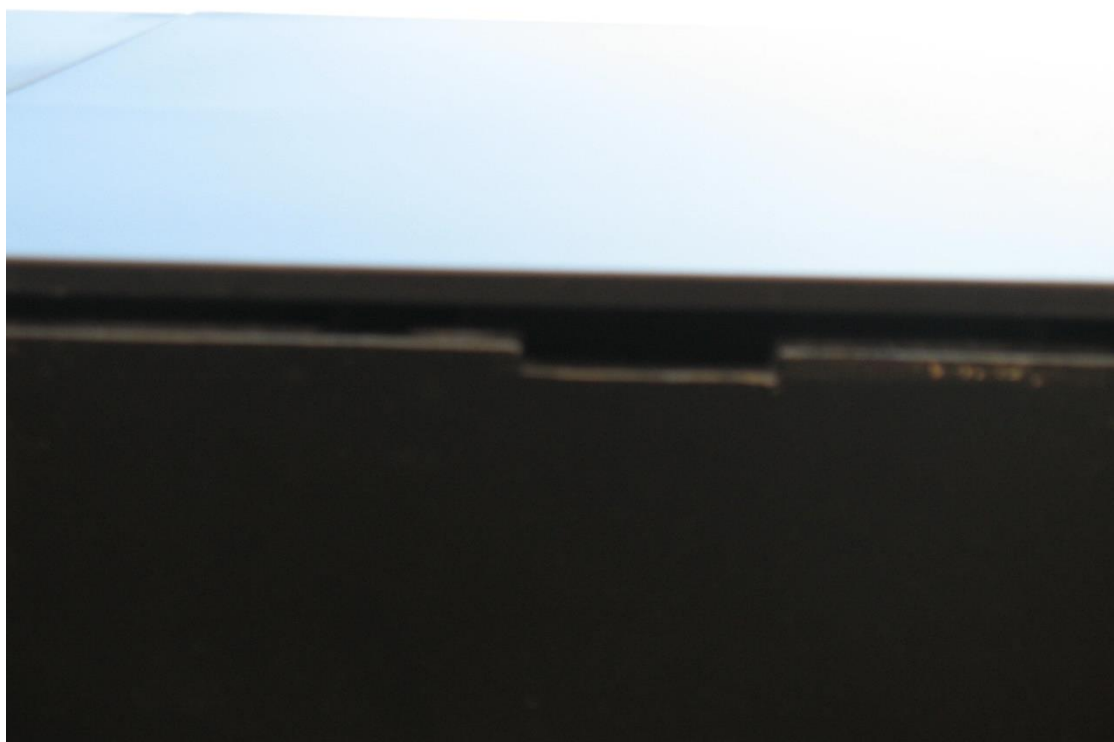
Figuur 7: Kieren tussen de brugwand en de koof
