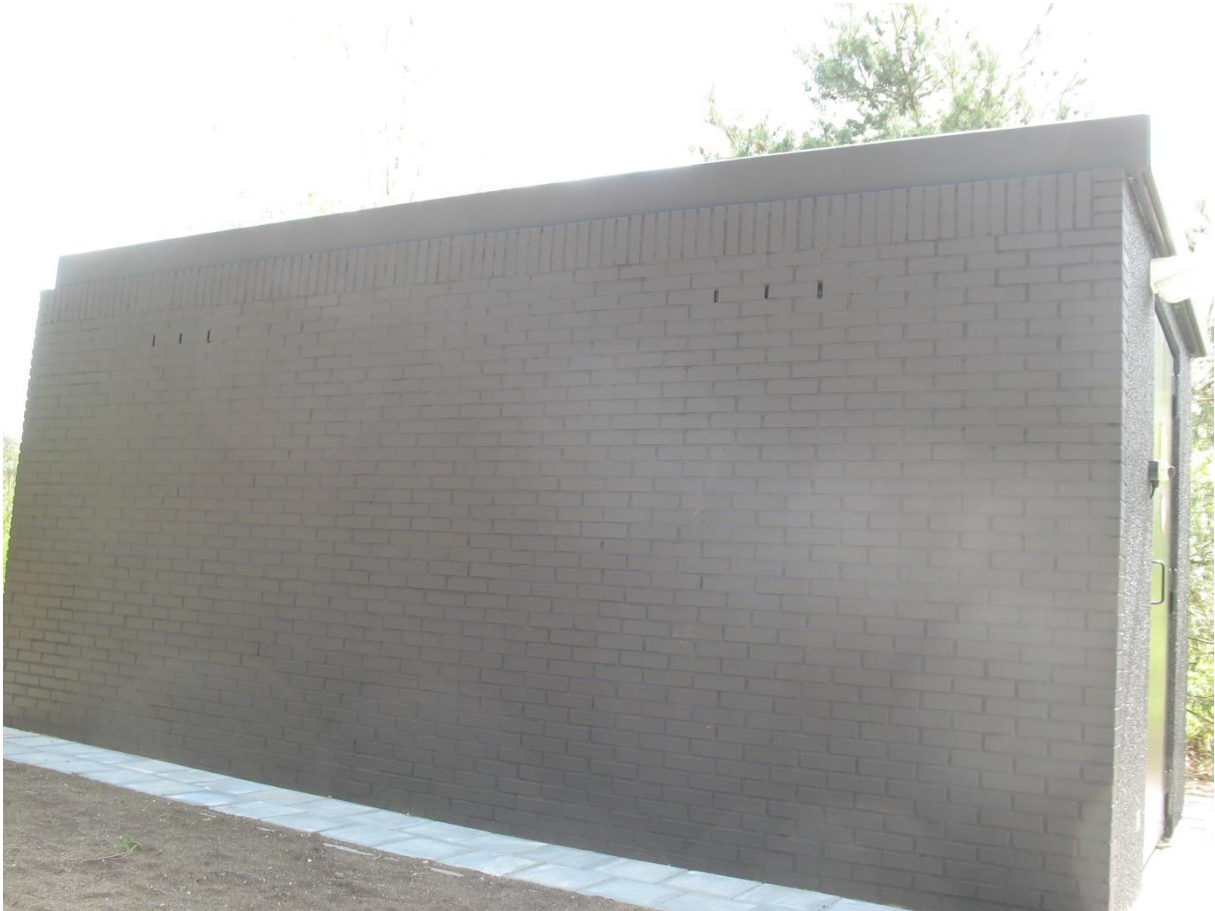
Figuur 4: Gebouw 274 met voorzetgevel en open stootvoegen
