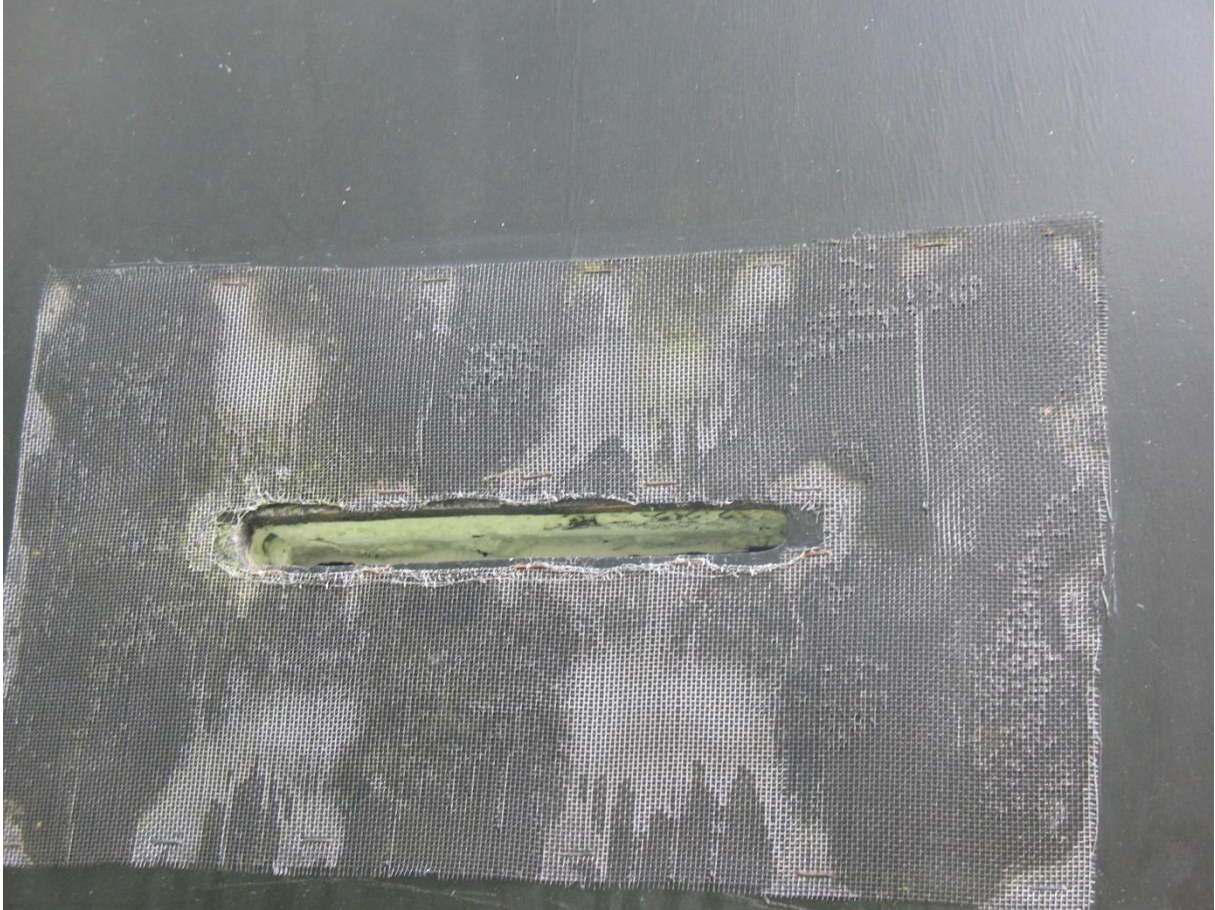
Figuur 8: Voorbeeld van gaas op een gladde ondergrond, zodat vleermuizen toch naar binnen kunnen kruipen
