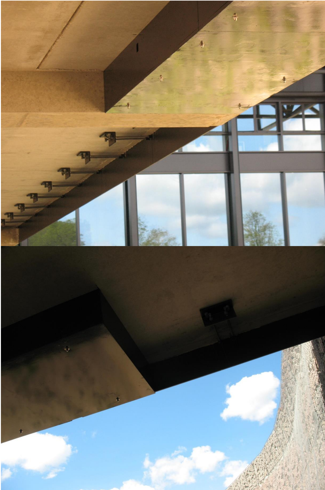
Figuur 6: Koof onder de brug naar museumgebouw Boven: De te gladde afwerking van de koof is goed te zien. Onder: ruimte tussen de schanskorf en koof, zodat roofdieren de koof niet kunnen bereiken.
