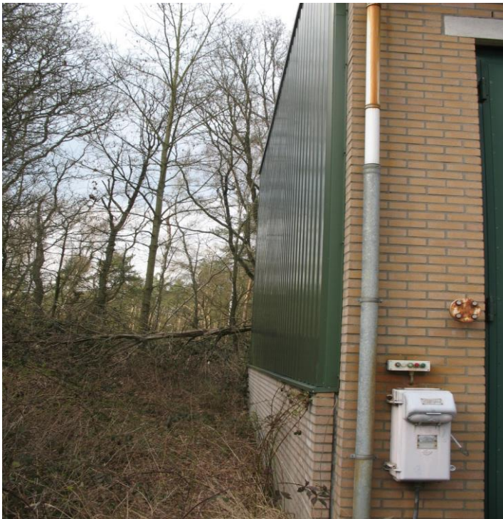
Figuur 1: Gebouw 267. De groene alu-gevelplaat is vervangen door een gemetselde muur.
