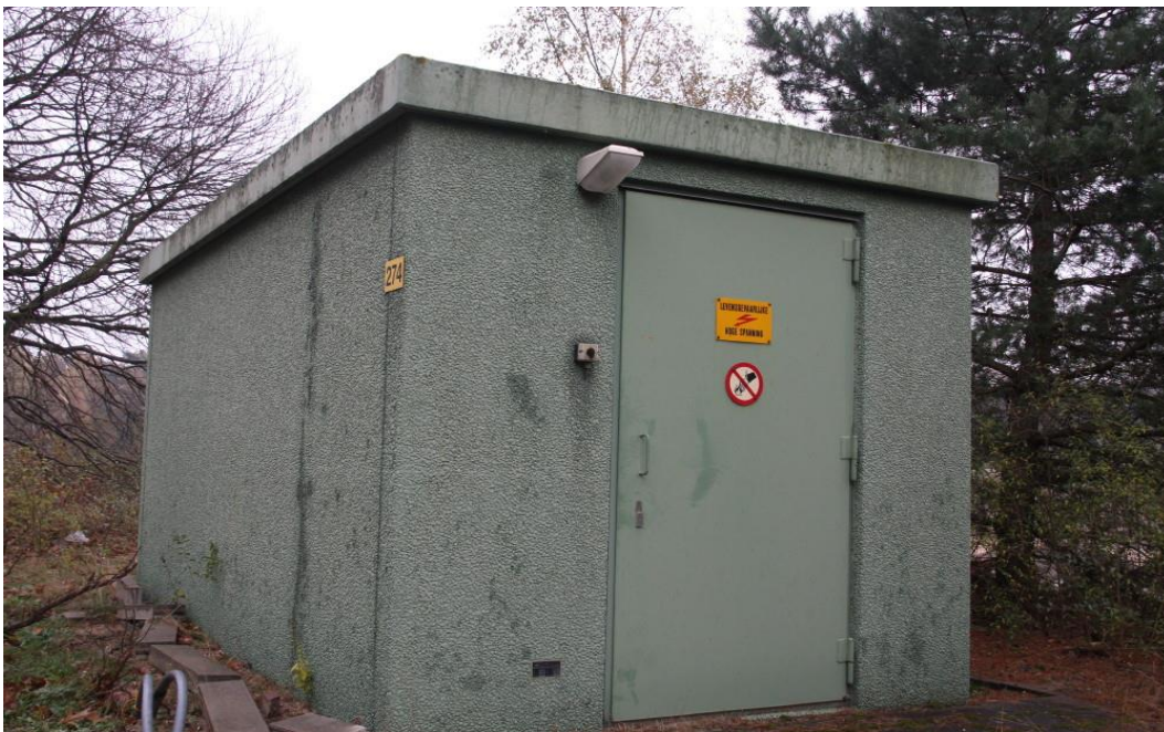
Figuur 3: Gebouw 274. Bij dit gebouwtje worden voorzetmuren gemetseld.
