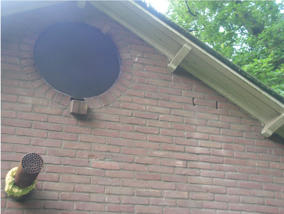
Figuur 5: Achterzijde gebouw 125, het rooster is dichtgemaakt, behalve bij het 'afwatergootje'
