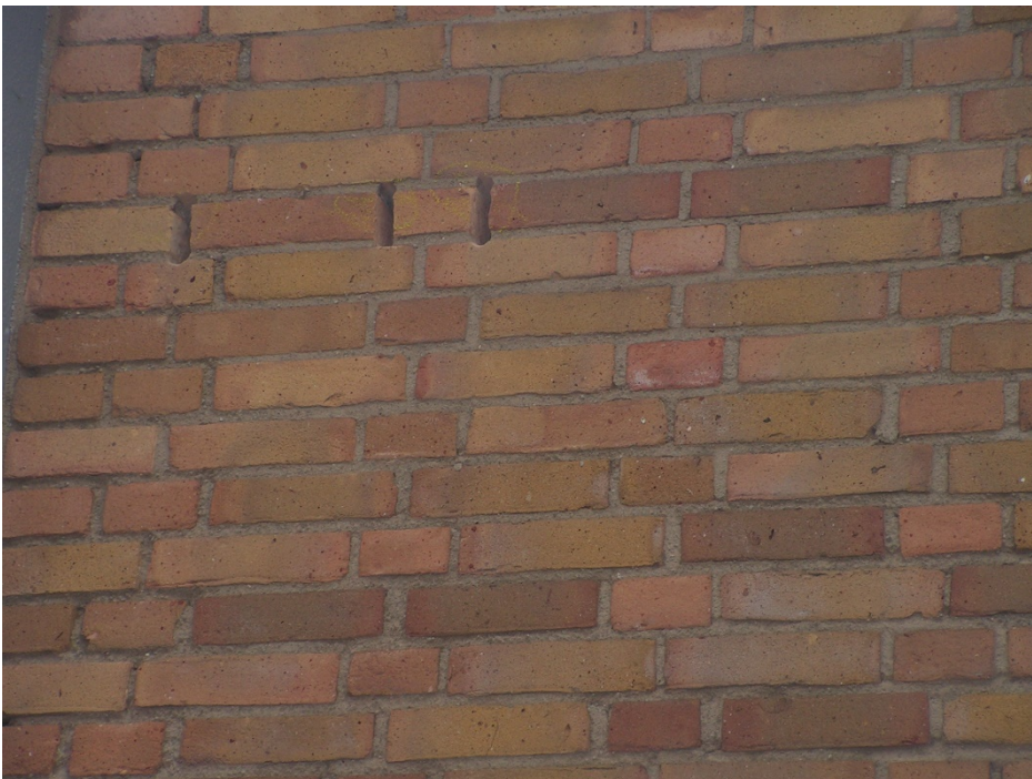
Figuur 2: Voorbeeld open gemaakte stootvoegen bij gebouw 130
