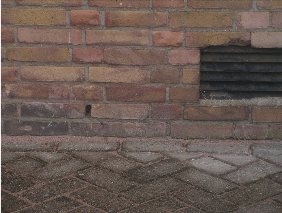
Figuur 1: Voorbeeld van open stootvoeg boven de grond en rooster bij gebouw 130.
