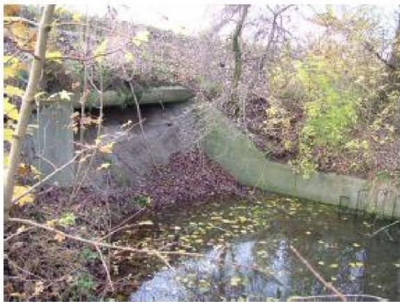
Afbeelding 2, zicht op de dichtgemaakte kokers oostzijde
