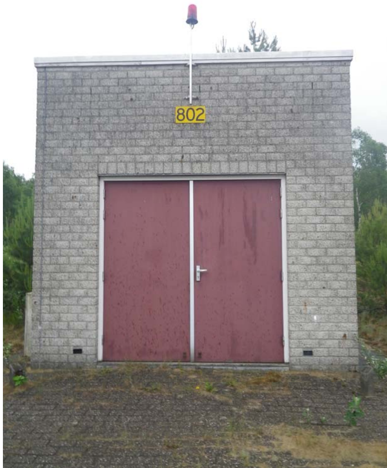
Figuur 1: Het aan te passen pompgebouwtje
