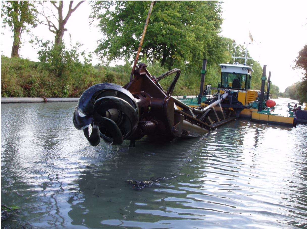
Figuur 2.2. De zuiger met snijkop van Verboon-Maasland, die is gebruikt om de Nieuwe Wetering te baggeren.
