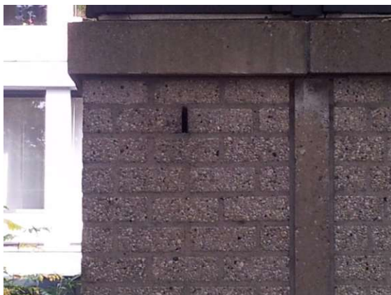
Figuur 3: voorbeeld toegankelijke stootvoeg
