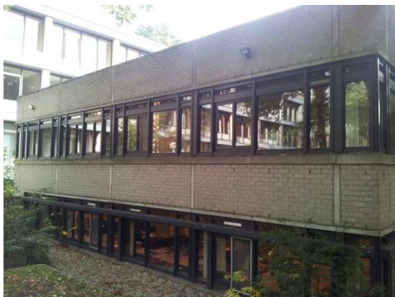
Figuur 2: Comeniuslaan 6; een gebouw met veel stootvoegen. Waarschijnlijk grotendeels gedicht met bijenklemmen.
