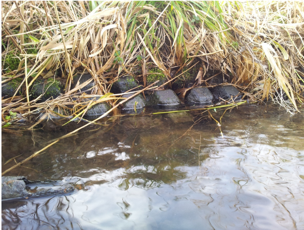
Figuur 5. Stenen beschoeiing zoals die langs grote delen van de Hoge Vaart voorkomt.
