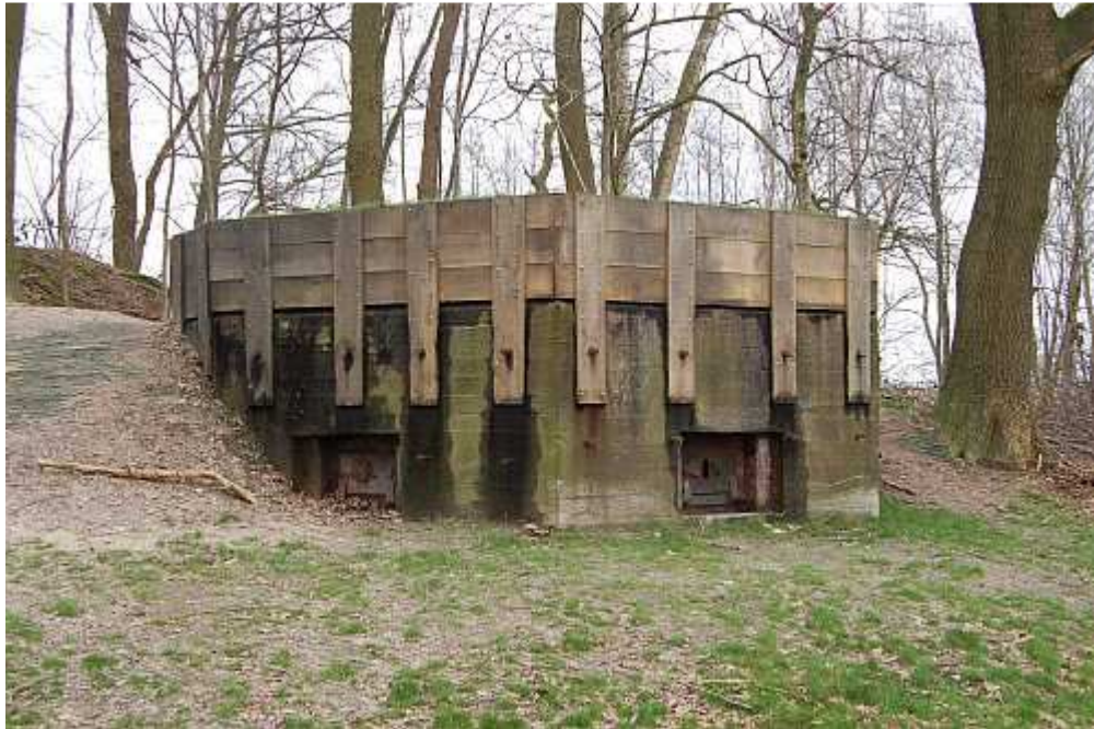
Figuur 6: Voorbeeld van een "bekiste" en aangeaarde S3-kazemat (Asschatterkeerkade te Leusden) met vleermuizen invliegopening via het schietgat middenvoor. Foto: Traces of War.
