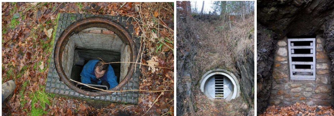
Figuur 8: Bewezen vandalisme bestendige toegangen: Een inspectieput en een afgesloten rioolbuis als "menselijke" toegang tot een vleermuiswinterverblijf. Rechts een siermuurtje met beton, 4 houders en 4 slotkasten. Rechter twee ontwerpen door ® J.
