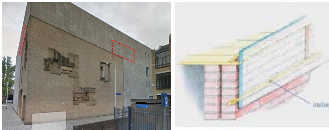
Figuur 4. Geschikte locaties voor een winterverblijfplaats achter de travertijnplaten.
