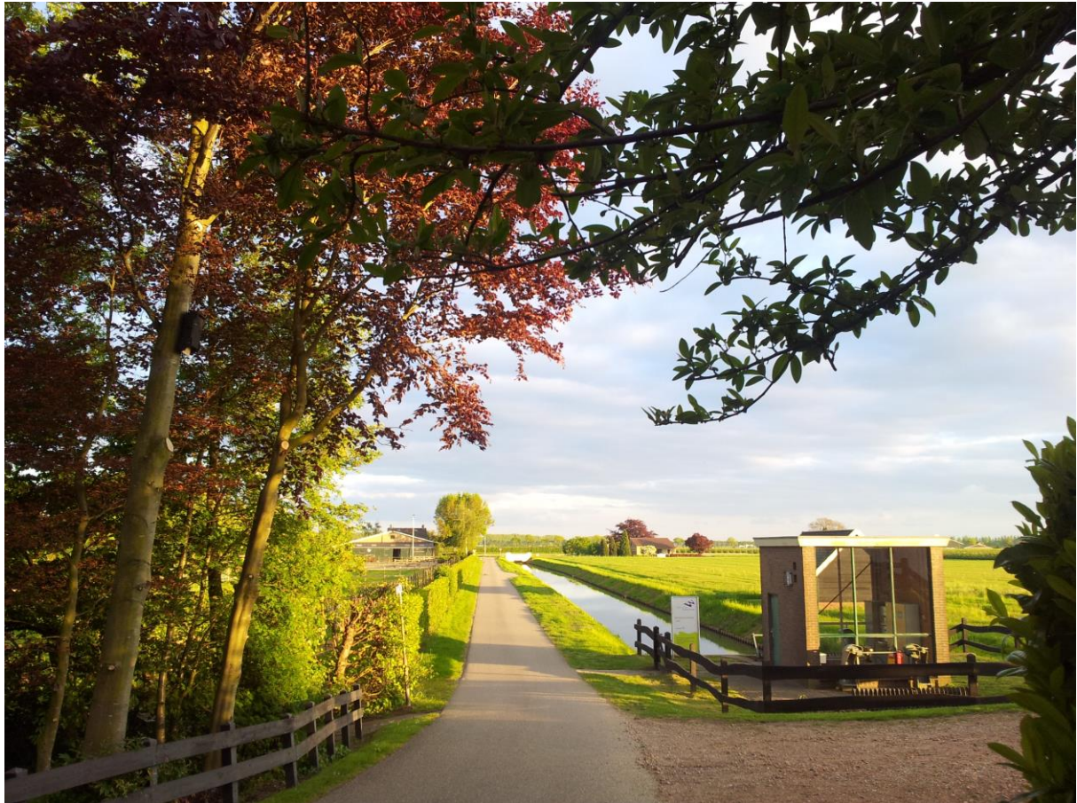
Figuur 2: Het te slopen gemaalgebouwtje de Vlinder, Deil
