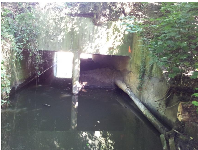
Figuur 1: De huidige situatie aan de zuidwestzijde
