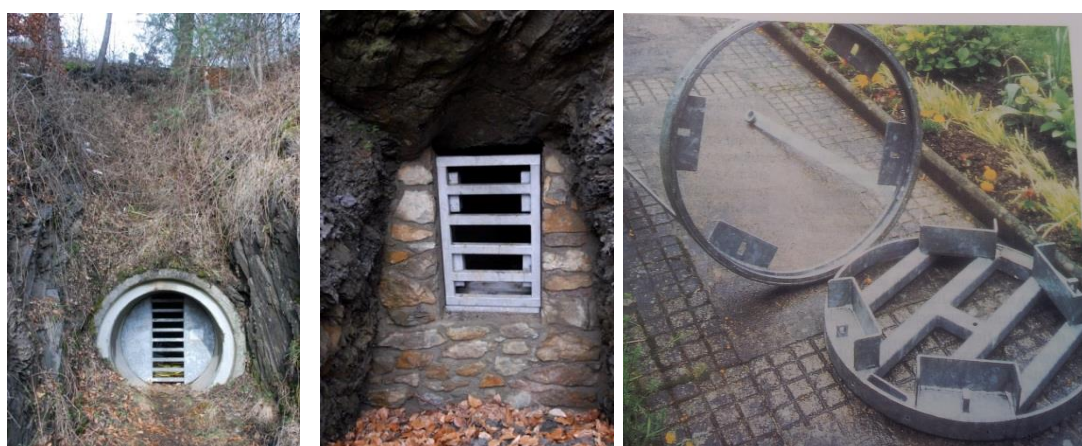
Figuur 3. Een vandalismeproof afsluiting van een groeve. De tralies zijn gevuld met beton en hard stalen staaf. Scharnieren binnen en hangsloten binnen in een slotkast. Achter de sierstenen muur zit een 60 cm dikke gewapende betonnen muur. Let op staven moeten altijd horizontaal worden aangebracht.
