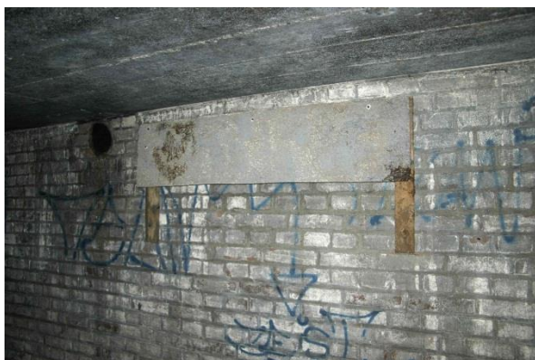
Figuur 5e: Wegkruipplaat (Hier een houtwolcementplaat op rachels).
